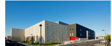
Equinix NY5 IBX exterior
